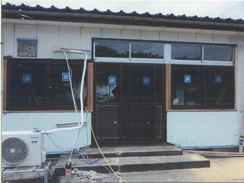
▲ティファニールームサッシ取替工事
