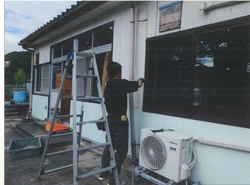
▲ 縦樋取替工事
