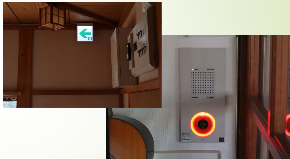
▲消防用設備設置工事・ブルーヒーター購入
