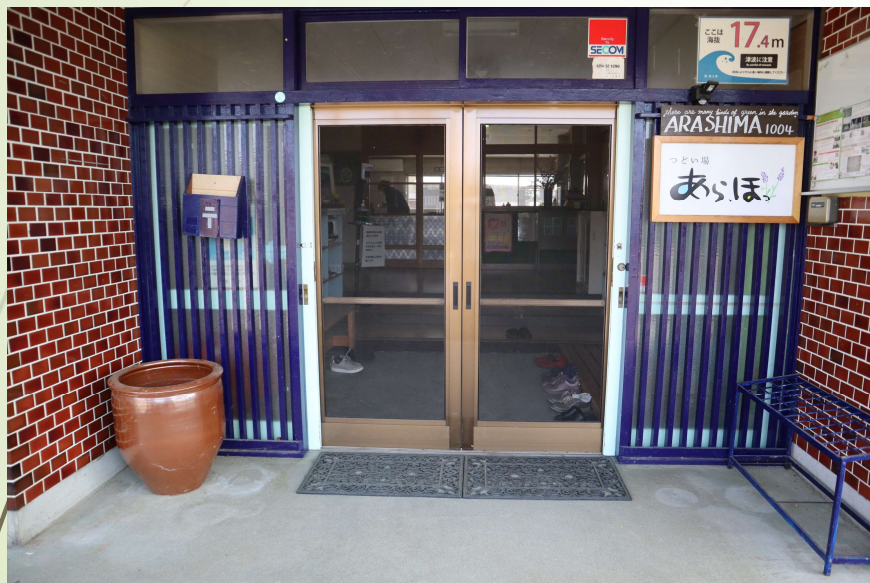
▲ 玄関網戸取付
